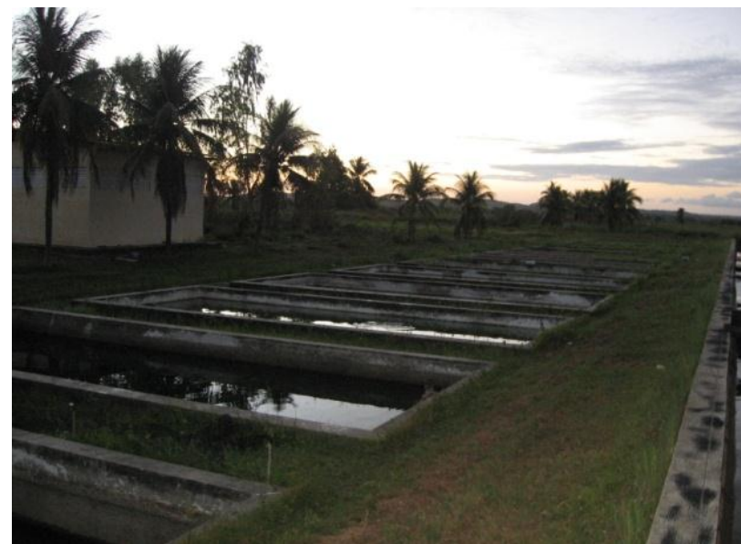
Tanques de alvenaria
